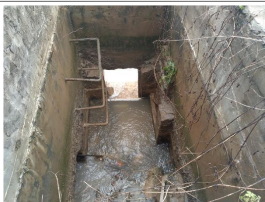
碳酸钙车间南面集水池
