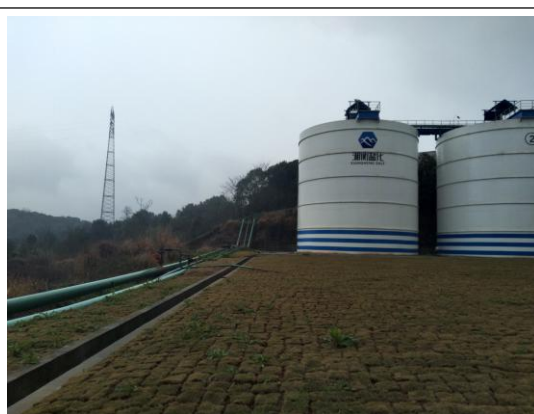
碳酸钙车间东面现有集水沟
