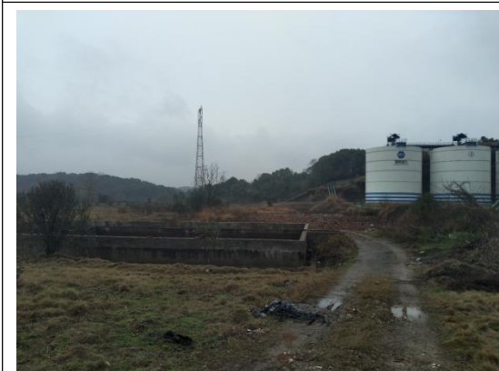
碳酸钙车间南面集水池
